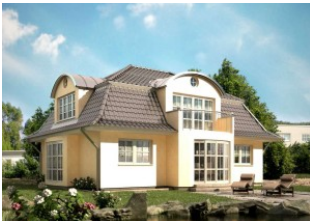
Stadthaus Villa „Villa 173/183“
